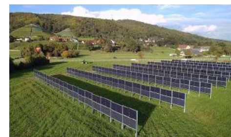
Agri-PV in Dresden Pillnitz @HTW Dresden
